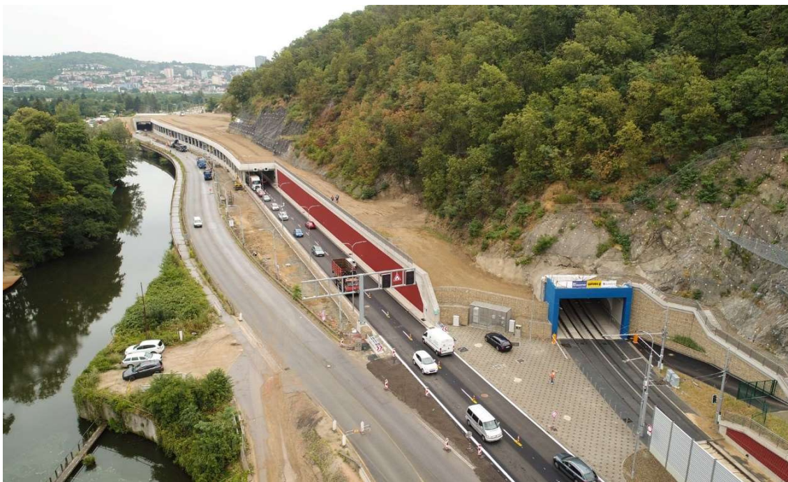
Pohled na Galerii VMO Žabovřeská v Brně od jihu.
