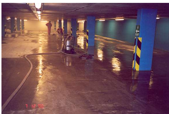
Najnižšie podlažie podzemných garáží pred hotelom Carlton po ukončení čerpania vody a po utesnení pracovných škár
