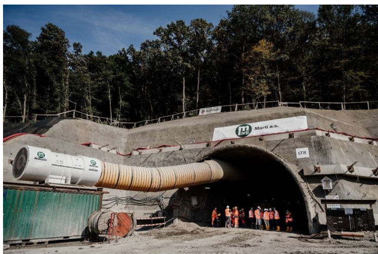
Ľavá tunelová rúra západný portál
