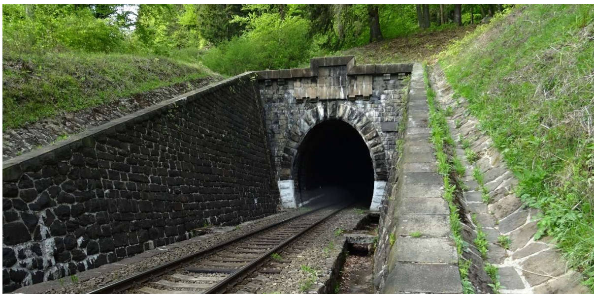
Handlovský portál (P2) Bralského tunela
