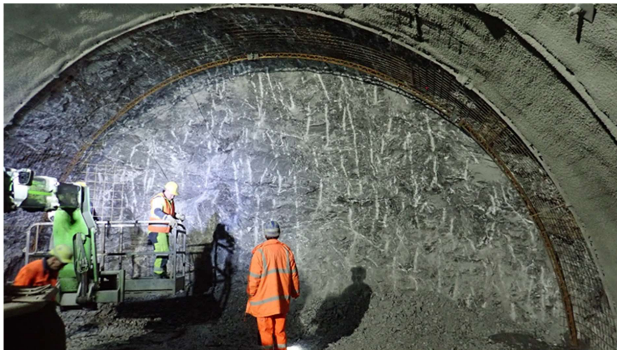
Čelba kaloty v slienitých vápencoch
