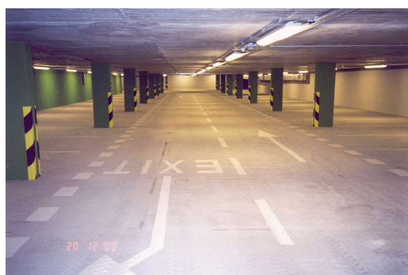
Najnižšie podlažie podzemných garáží pred hotelom Carlton po ukončení čerpania vody a po utesnení pracovných škár
